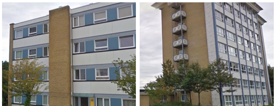
Figur 8 - Bygningen på venstre billede er opført med bærende murværk og huldæk og bygningen til højre er opført med konstruktioner i in-situ støbt beton
