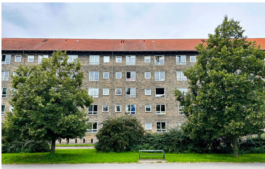
Figur 4 – Eksempel på etageejendom opført af fuldmurede facader.
