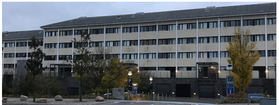
Figur 7 - Eksempel på et etagebyggeri opført i betonelementer i perioden 1970-1973, hvor systemet med bærende indvendige betonavægge er anvendt.
