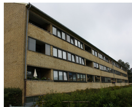
Figur 9 - Betonelementbyggeri med bærende betonskillevægge.
