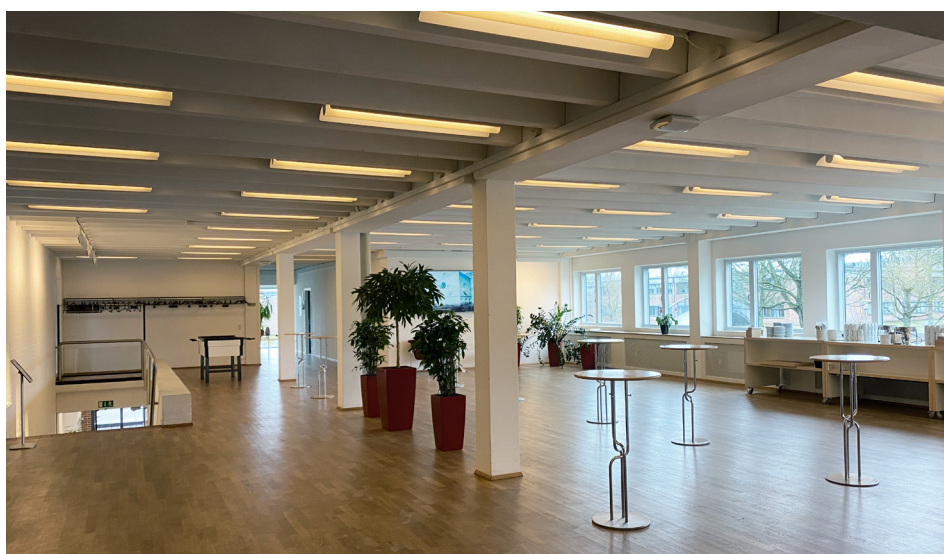
Figur 13 - Eksempel på en kontorbygning med betonelementer opført med søjle/bjælkesystem og ribbeelementer som etageadskillelse.
